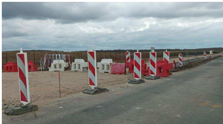
Figure 3 : travaux de voiries - route forestière fermée
